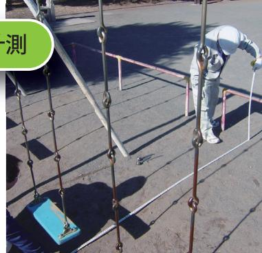
安全領域の測定やプランクなどの鎖のエンドリンク測定の他、照明灯などでは絶縁抵抗測定なども行います。
