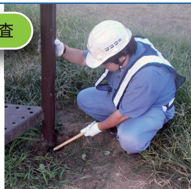
ハンマーによる異常音の聞き取りを行います。木材の腐朽、鋼材の腐食やボルトの緩みなどの異常がわかります。
